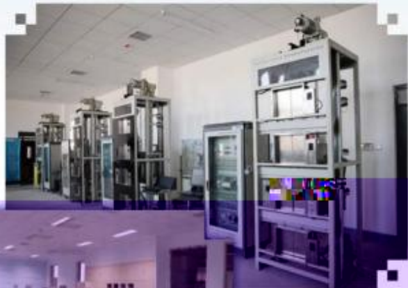
智能电梯安装调试 维护训练场所
